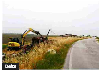
Porto Tolle, sistemazione delle lagune: cantieri in partenza
